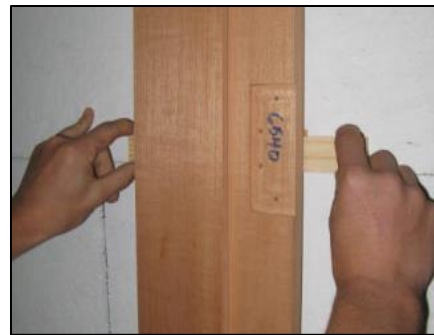
Figura 5: colocación de la calza 2
