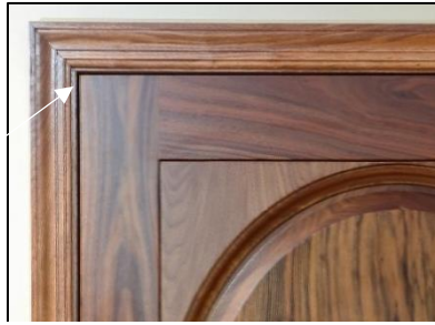
Figura 3: comprobar el espacio de la puerta
